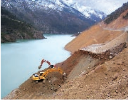
Teleferik taşıma hattı indirme bölgesi istinat duvarı ve erişim yolu çalışması.
