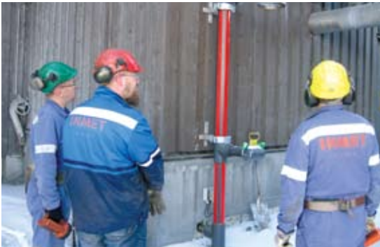
Pyhäsalmen rikastamossa kemikaalien käsittelytilojen lähellä tarkastetaan ja testataan uutta suihkua.
